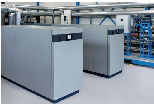
Pompy ciepła Vitocal 350-G o całkowitej mocy 620 kW
