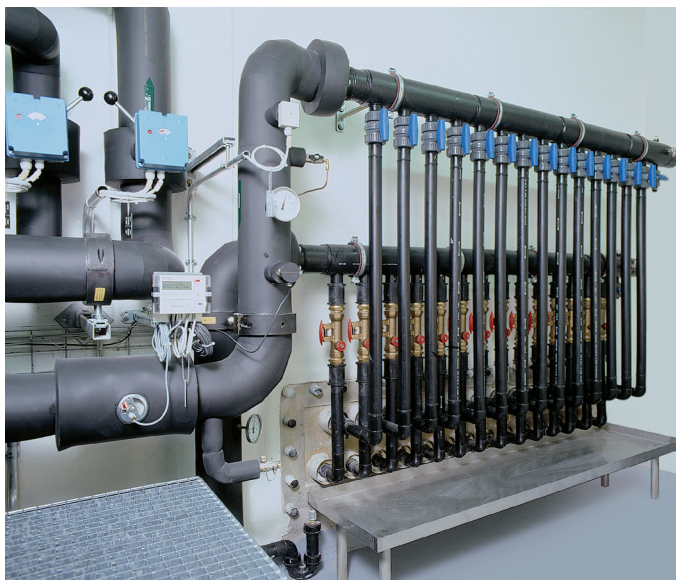
Rozdzielacz sond gruntowych
