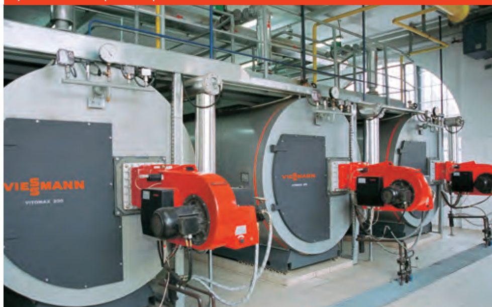
Rys. C.1.2-1 Kotłownia parowa w szpitalu
