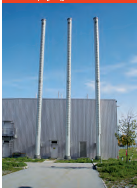
Rys. C.10-1 Instalacja odprowadzania spalin (Dingolfing)
