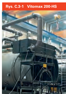
Rys. C.3-1 Vitomax 200-HS Vitomax 200-HS z przegrzewaczem, 22 t/h, 10 bar, podczas budowy, (zainstalowany został na Litwie).
