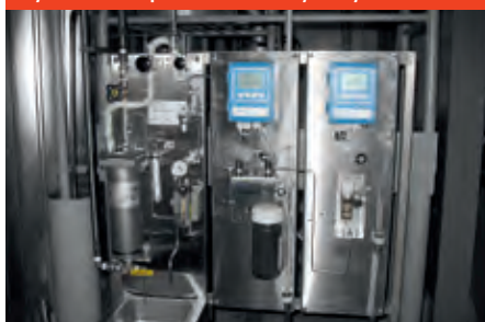
Rys. C.6.4-2 Aparatura do analizy wody
