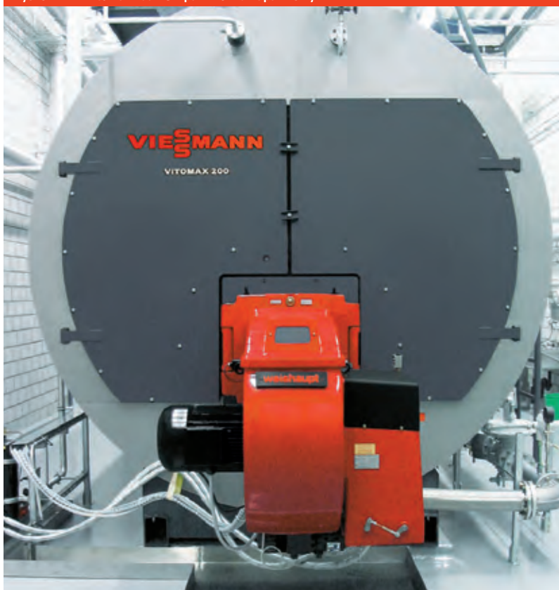
Rys. C.4.4-2 Vitomax 200-HS z palnikiem dwupaliwowym
