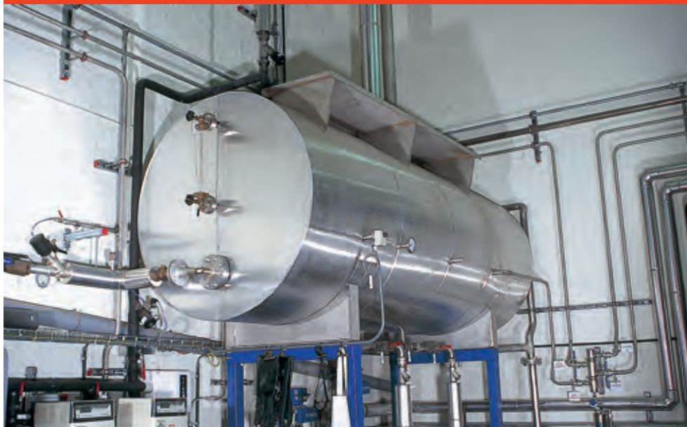
Rys. C.5.3.2-2 Odgazowywacz częściowy
