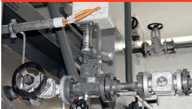
Rys. C.1.1-6 Zawór odsalający
