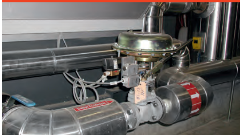
Rys. C.1.1-4 Zawór odmulający
