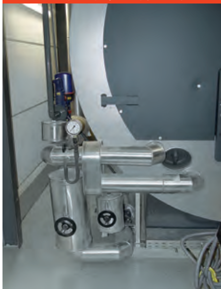
Rys. C.1.3.1-1 Utrzymywanie ciśnienia przy pomocy węzownicy grzewczej
