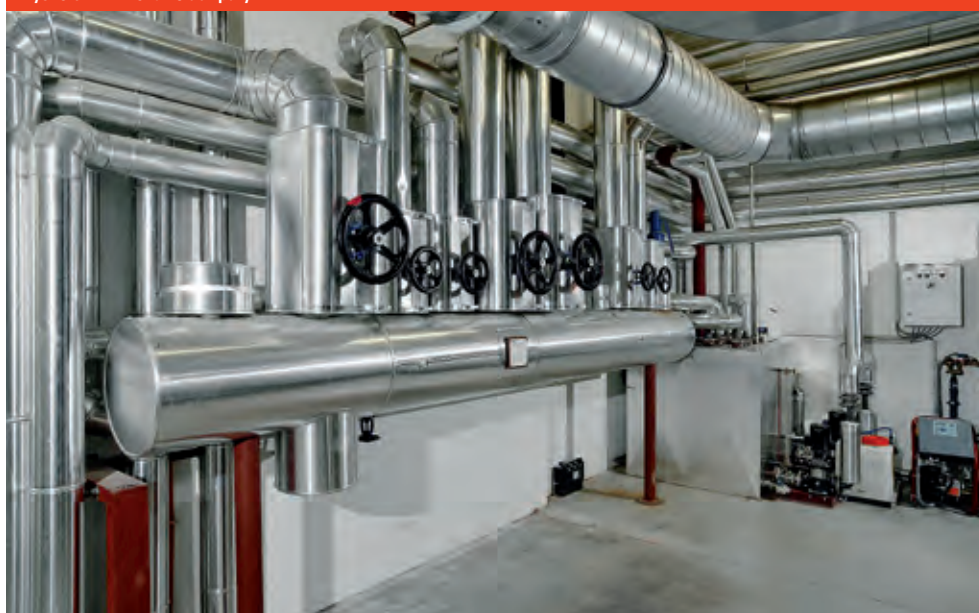
Rys. C.9.1-2 Rozdzielacz pary
