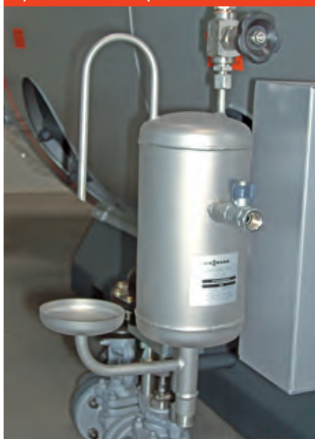
Rys. C.6.4-1 Chłodnica próbek
