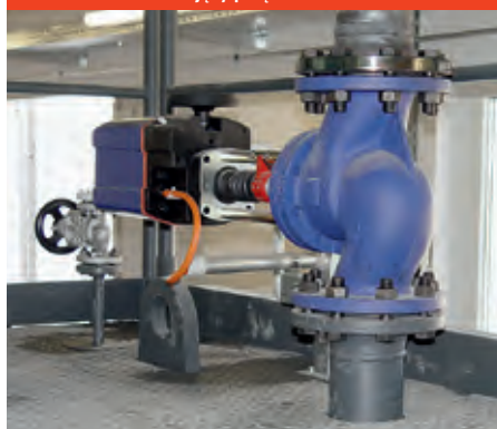
Rys. C.1.2-3 Zawór sterowany silnikiem odcinający parę
