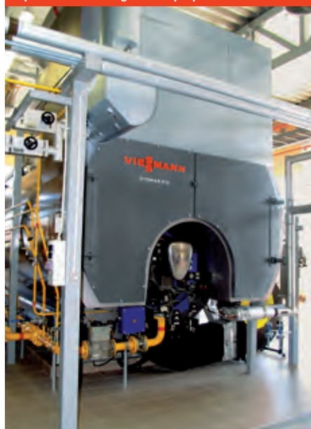
Rys. D.2.3.4-3 Przegrzewacz pary
