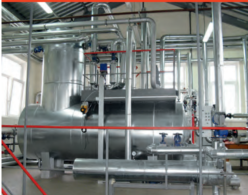
Rys. D.5.3-2 System pełnego odgazowania termicznego
