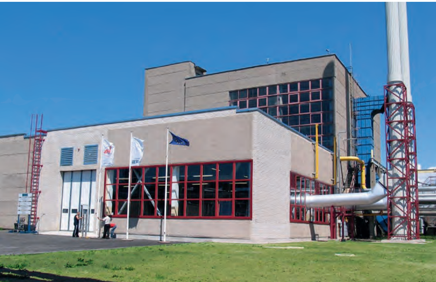
Kotłownia z 2 kotłami Vitomax 200-HS po 10 t/h każdy, 16 bar z regulowanymi przegrzewaczami pary i dostawionymi podgrzewaczami wody w Kłajpedzie (Litwa), ciepłownia firmy Klaipedos energija, rok budowy 2007.
