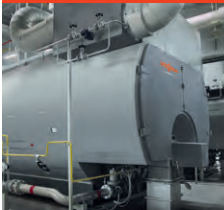
Rys. D.2.3.4-5 Kocioł parowy z przegrzewaczem
