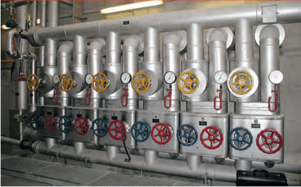
Rys. D.8.5.1-3 Rozdzielacz pary
