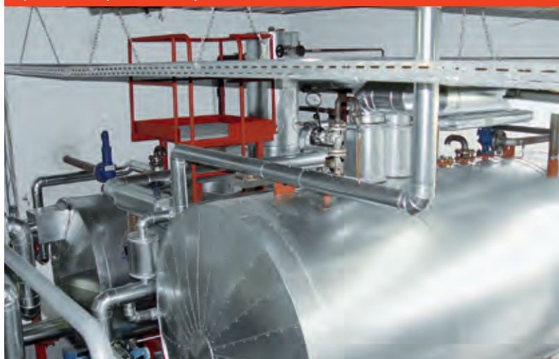
Rys. D.5.1.1-2 Wysokociśnieniowy zbiornik kondensatu
